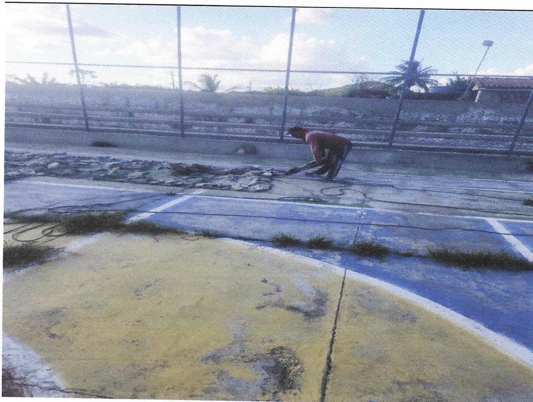
DEMOLIÇÃO DA QUADRA
