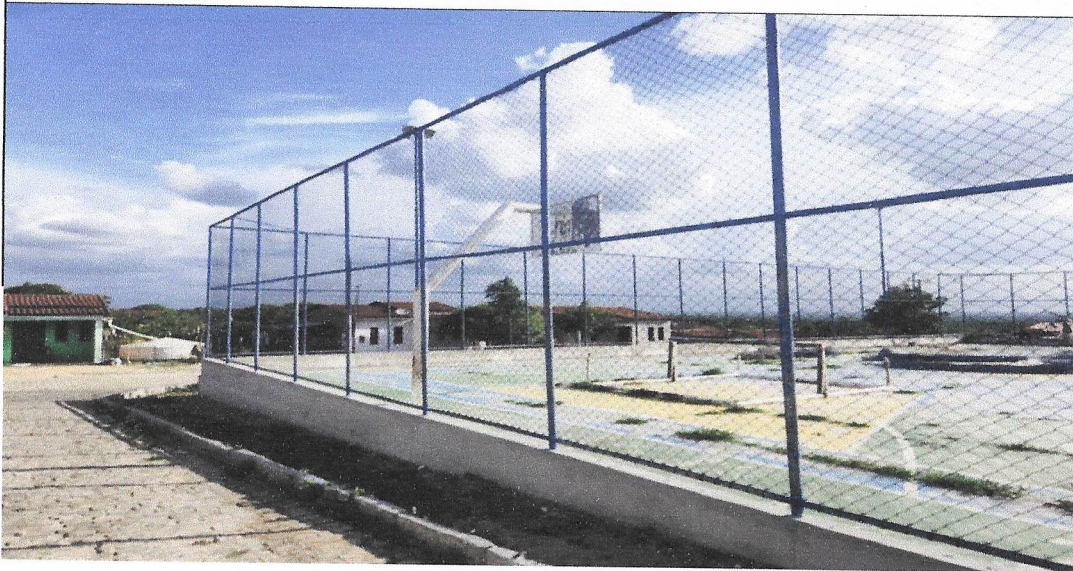
DEMOLIÇÃO DA QUADRA
