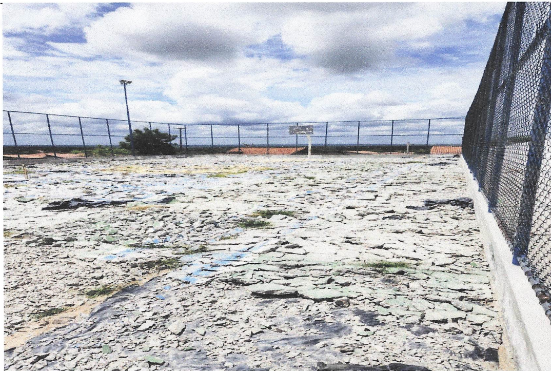
RETIRADA DA DEMOLIÇÃO
