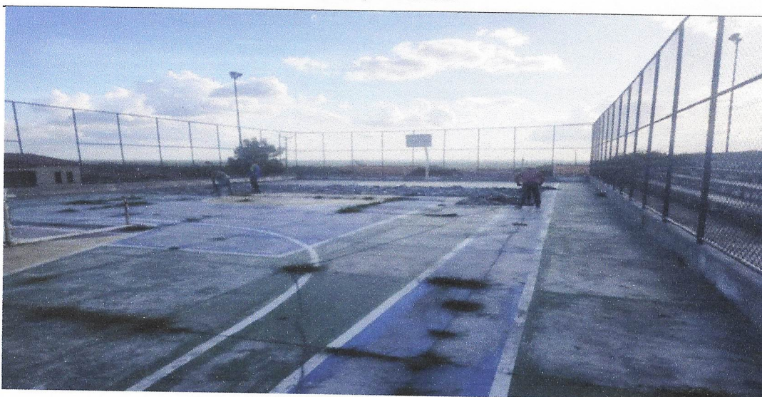
DEMOLIÇÃO DA QUADRA
