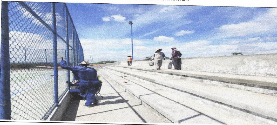
EXECUÇÃO DA ARQUIBANCADA
